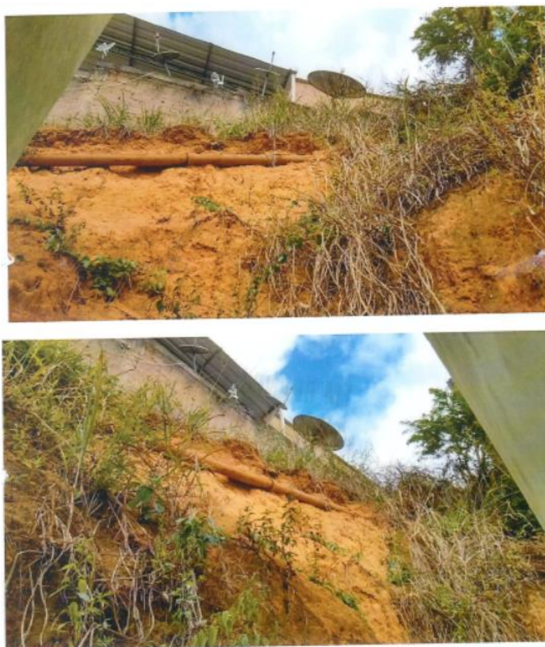
Figura 5 – Situação atual da adutora de água bruta na chegada da ETA. Fonte: CESAN – protocolo 2015.024078.
